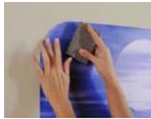
4. Lipeste apasand cu un burette pentru a elimina golurile de aer
